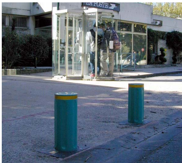
La poste de Vedène, Vaucluse, France Bornes escamotables mécaniques Ø200 H500
